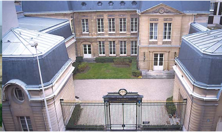
Façade rue Cérés
